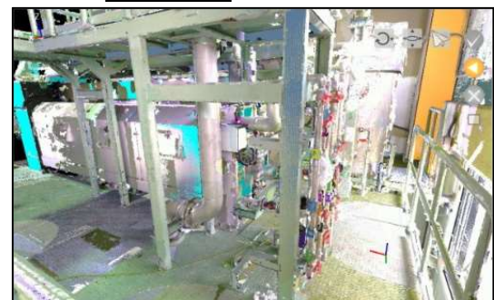
図-2 点群測量により計測した点群データ
