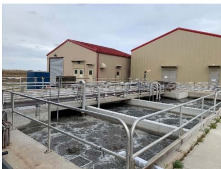
左:写真1 最先端の下水道システム(MBBR法: Moving Bed Biofilm Reactor)
