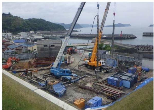
写真-4 ARハンマ工法による施工
