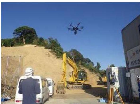
写真-3 ドローン及びTSによる測量
