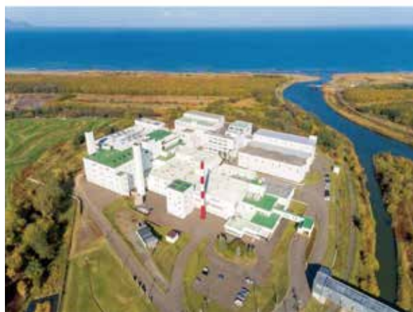
写真 1 西部スラッジセンター全景 （札幌市下水道資源公社パンフより）
