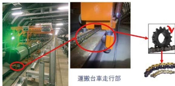
写真2 シールド共同溝内配管（配管運搬台車の使用）
