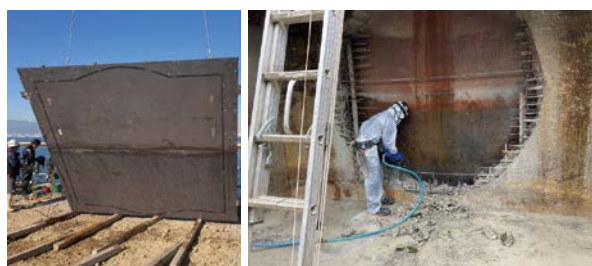
写真5 海中部への吐口設置
