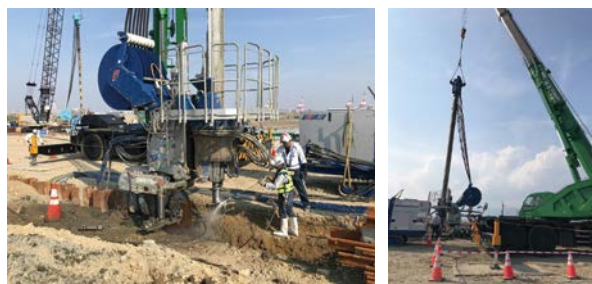
写真4 クラッシュパイラーの採用 (硬質地盤対応)
