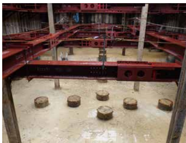
写真6 現場施工状況② (10月時点)
