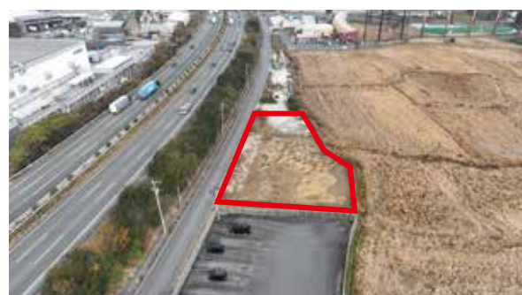
写真3 現場着工前状況
