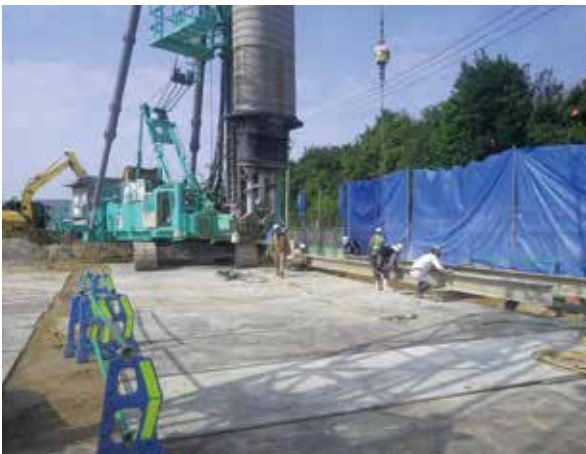
写真 4 SMW 施工状況
