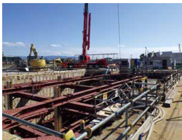
写真5 現場施工状況① (10月時点)
