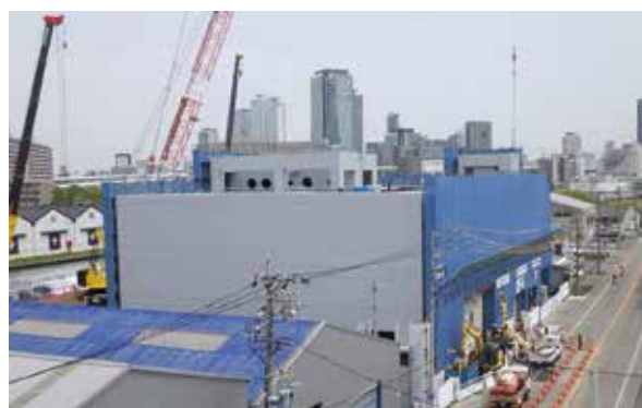
写真1 工事現場の外観（令和5年4月18日撮影）
