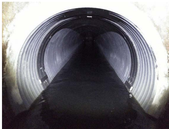
写真3 管更生による流入渠の健全化
