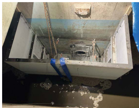
写真7 ゲート更新のための仮設止水板
