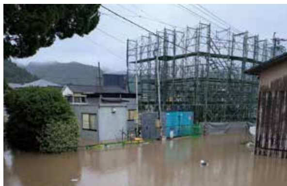
写真3 姫城2号排水機場周辺 浸水状況
