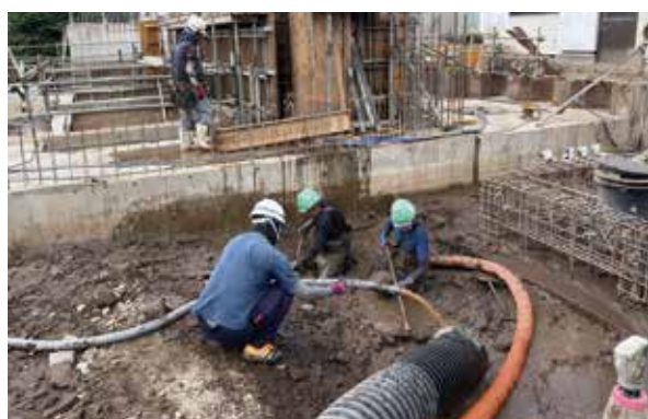
写真4 姫城2号排水機場 清掃状況
