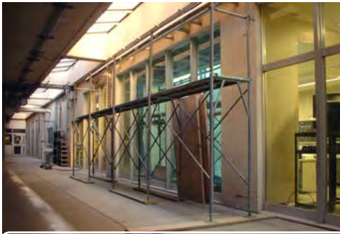
RC耐震壁の増設による耐震補強
