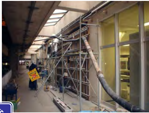
地盤改良による建物の沈下抑制・基礎補強
