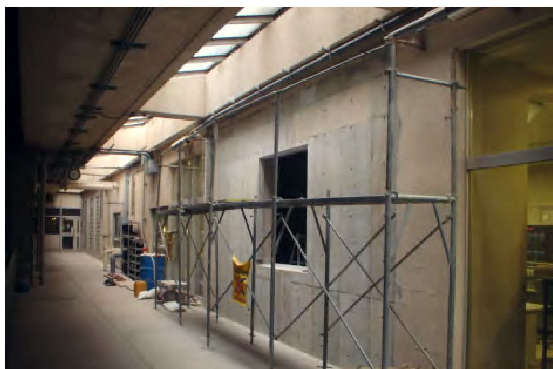
RC耐震壁の増設による耐震補強
