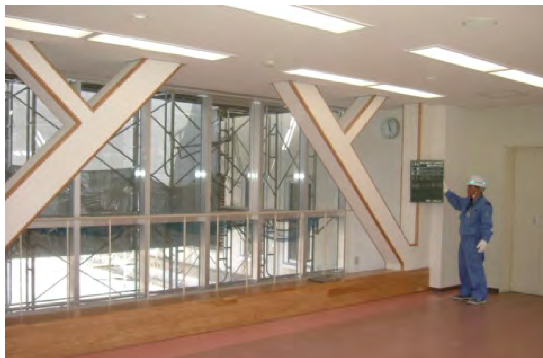
枠付き鉄骨ブレースによる耐震補強
