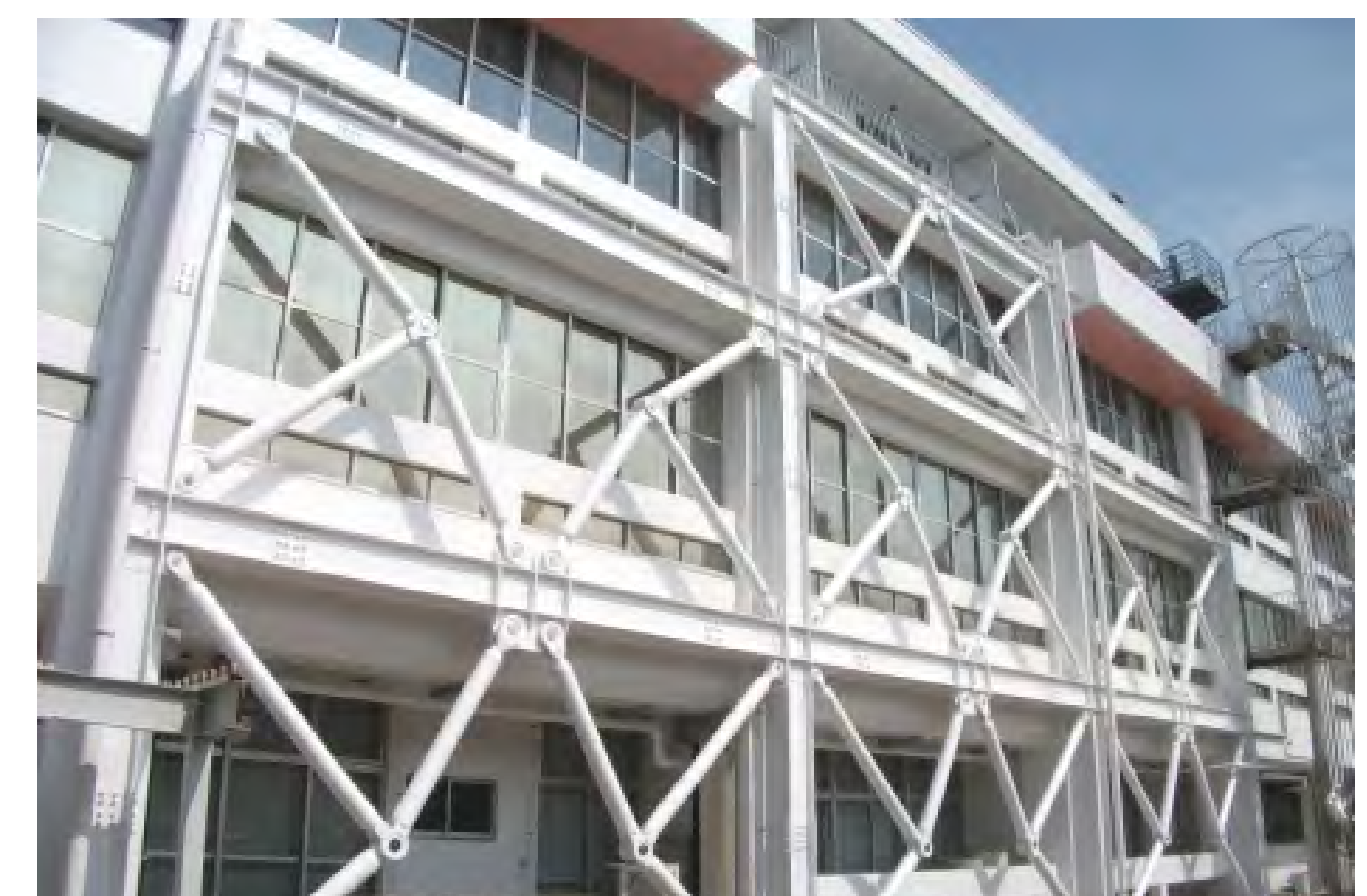
増幅機構付き制震装置による制震補強
