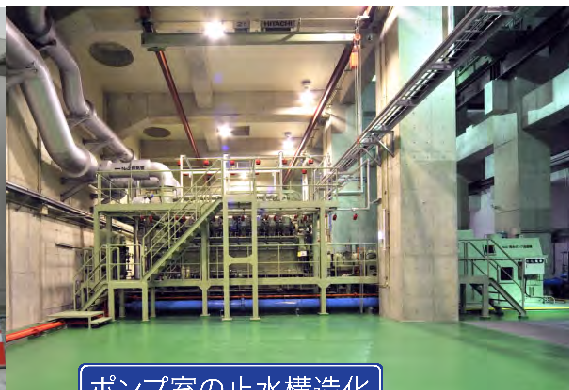
ポンプ室の止水構造化
