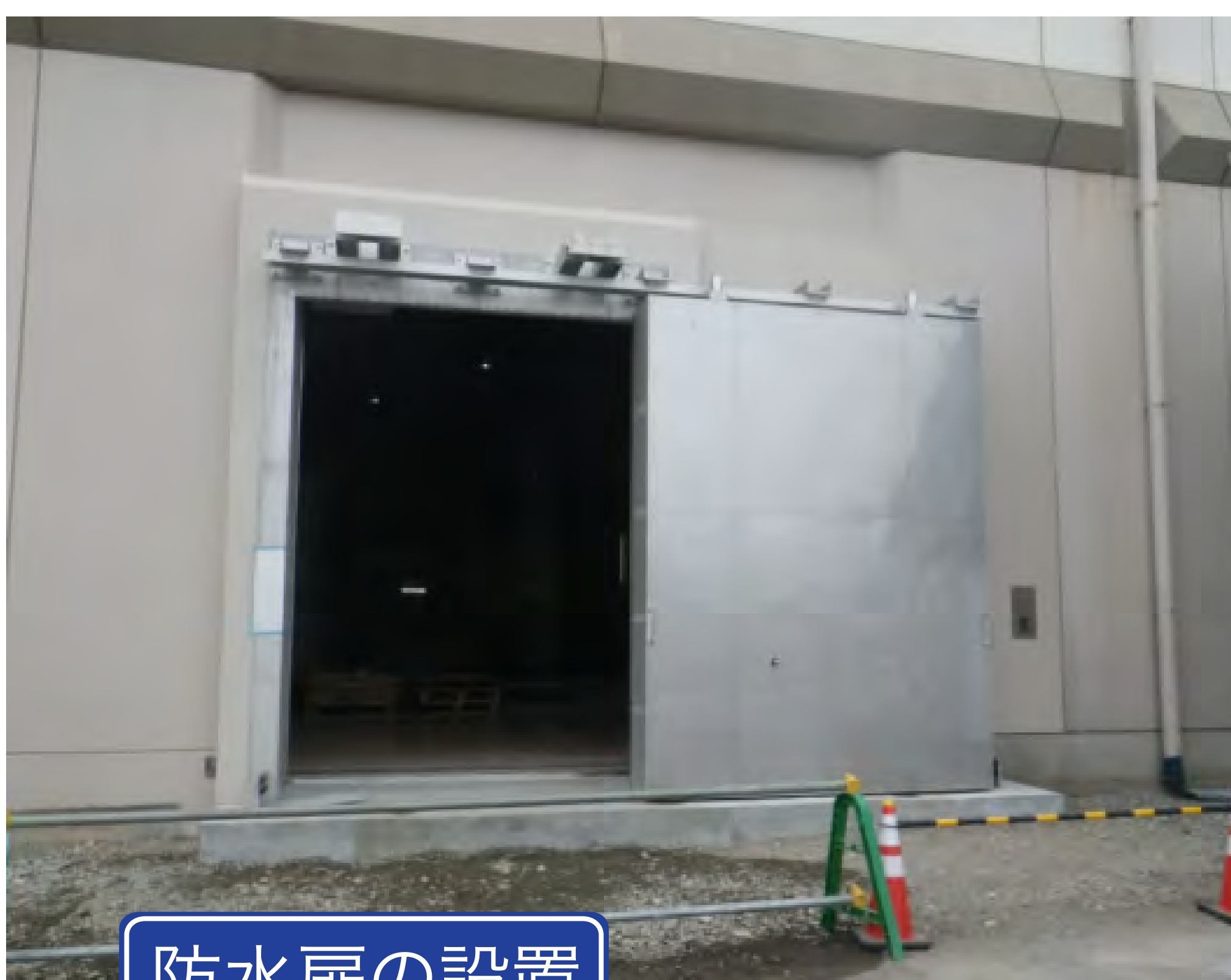
防水扉の設置
