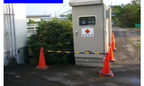
仮設電源盤設置
