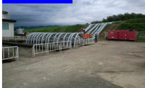
仮設水中ポンプ設置
