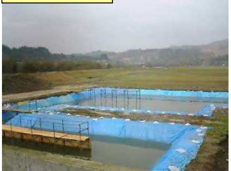
仮設沈殿池等設置
