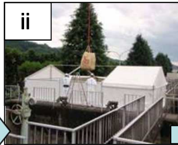
脱水汚泥の移送状況
