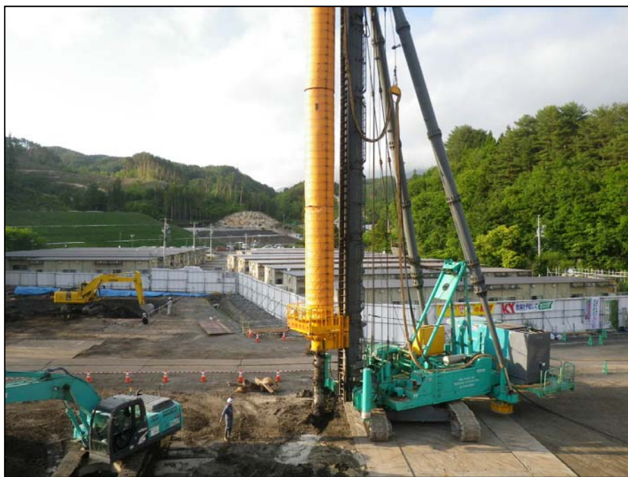
基礎工(地盤改良)施工
