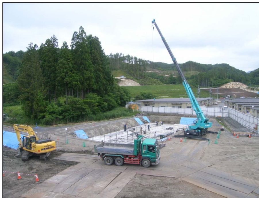
管理本館施工
