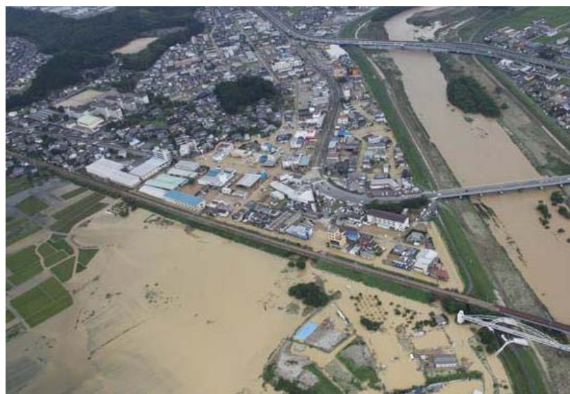
写真1 市内の浸水状況
