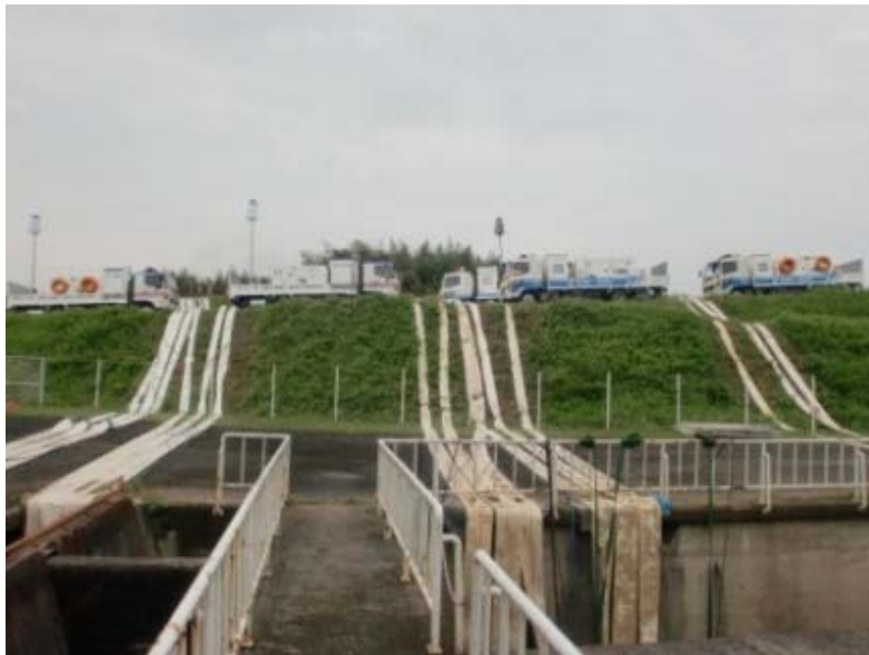
写真5 排水ポンプ車配備状況
