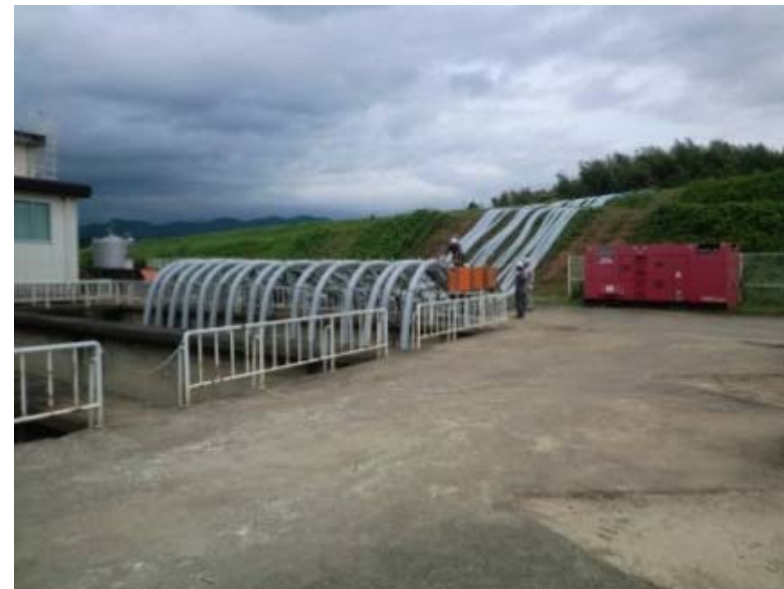
写真6 仮設水中ポンプ設置状況
