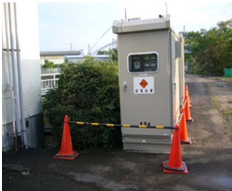
写真7 仮設電源盤設置
