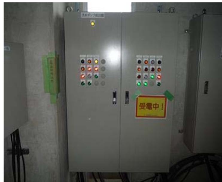
写真8 仮設制御盤設置
