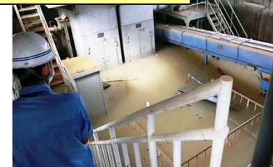
仮設沈殿池設置
