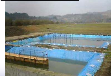
仮設沈殿池設置
