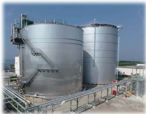
▲ 鋼板製消化タンクの導入事例（愛知県・矢作川浄化センター）
