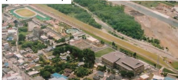
(境野処理区) 境野水処理センター
