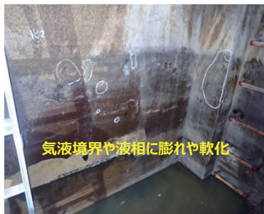
調査対象箇所 (濃縮汚泥受槽/13年間供用)
