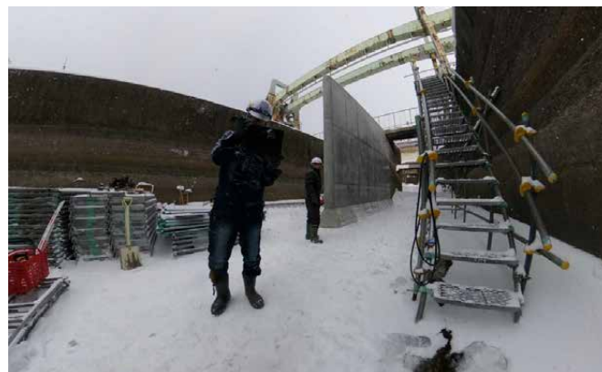
現場での検査状況
