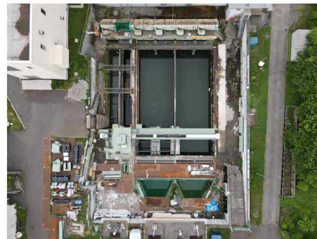
施設全体の写真 (施工中)
