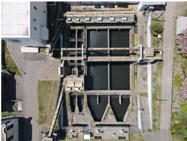
施設全体の写真 (着手前)
