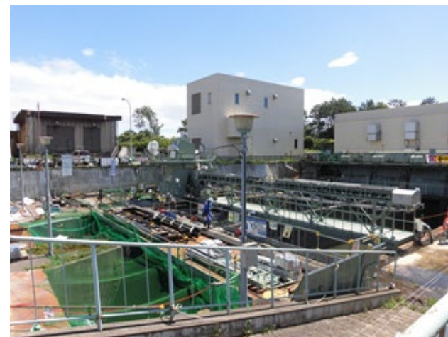
スクリーン設置施工中の写真
