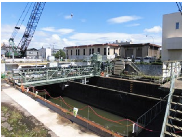
スクリーン設置施工中の写真
