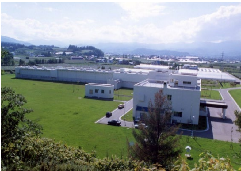
余市下水処理場
