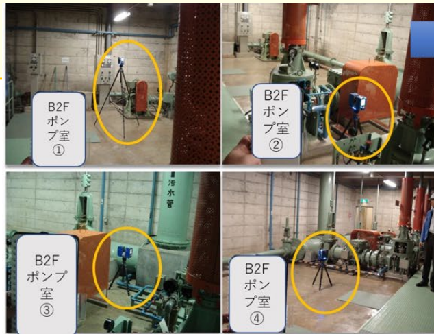
レーザーによる点群データ取得
