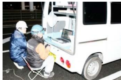
管渠の点検実施例
