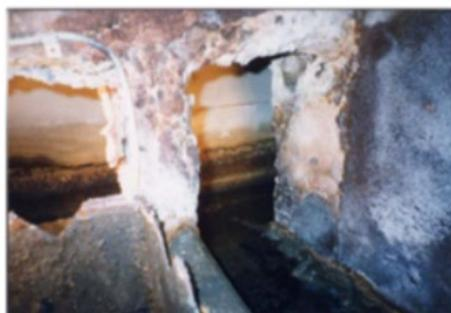
コンクリートの腐食対策において、特に、既存施設の補修では、新設時と異なり、腐食劣化診断とこれに基づく腐食・劣化部分の除去（はつり）、断面の修復、さらに施工の際の仮設や既存施設の運転切り廻しの検討なども必要になります。
