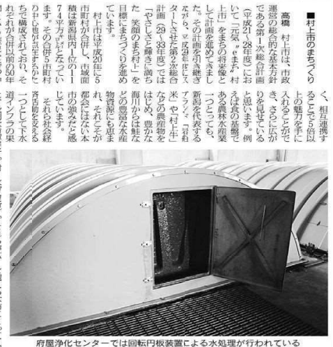
府屋浄化センターでは回転円板装置による水処理が行われている
