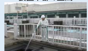
清掃作業状況
