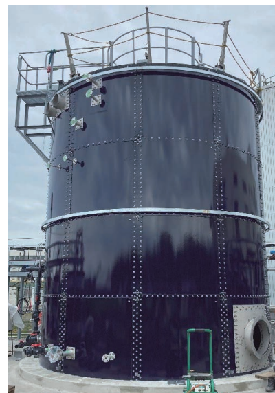
〈消化タンク外観（保温施工前の状態）〉
