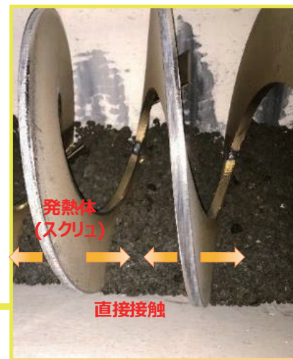
汚泥と発熱体(スクリュ)の接触状況
