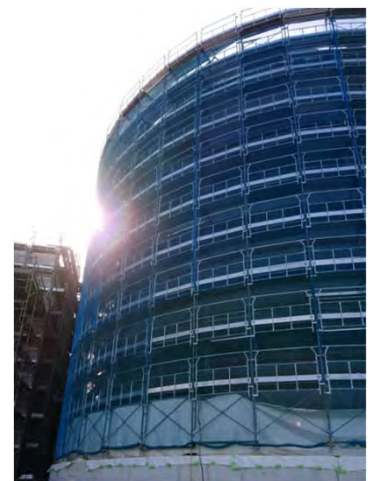
鋼板製消化タンク本体の建設状況
