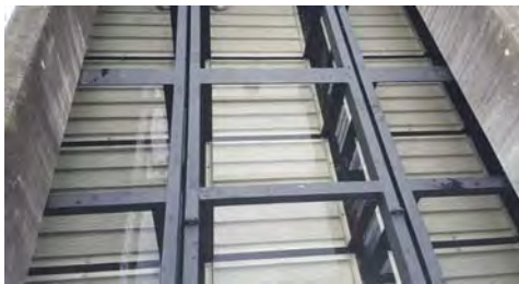
ろ材部設置状況写真
