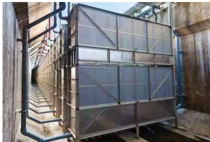
膜ユニットの設置状況例
