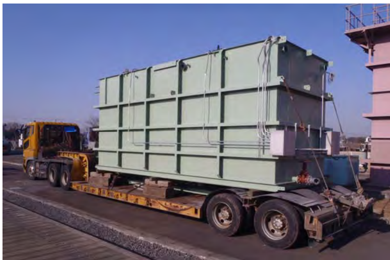
可搬式ユニットの運搬状況 (単槽式MBRユニットの反応タンク部)
