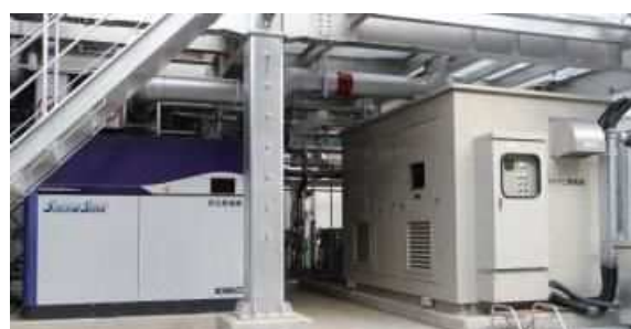
スクリュ式（左）とバイナリー式（右）発電機
