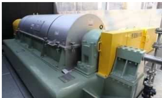
機内二液調質型遠心脱水機
