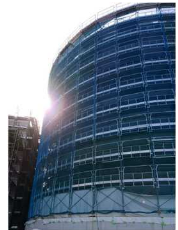
鋼板製消化タンク本体の建設状況
