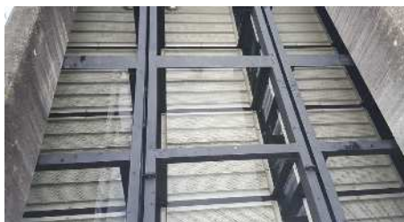
ろ材部設置状況写真
