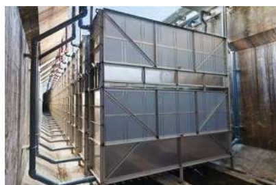
膜ユニットの設置状況例
