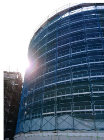
鋼板製消化タンク本体の建設状況
