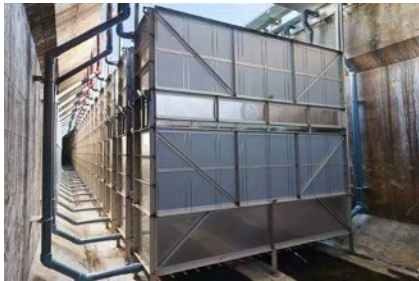
膜ユニットの設置状況例
