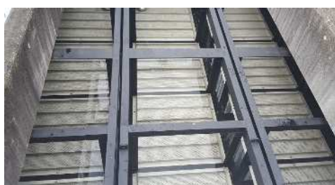
ろ材部設置状況写真
