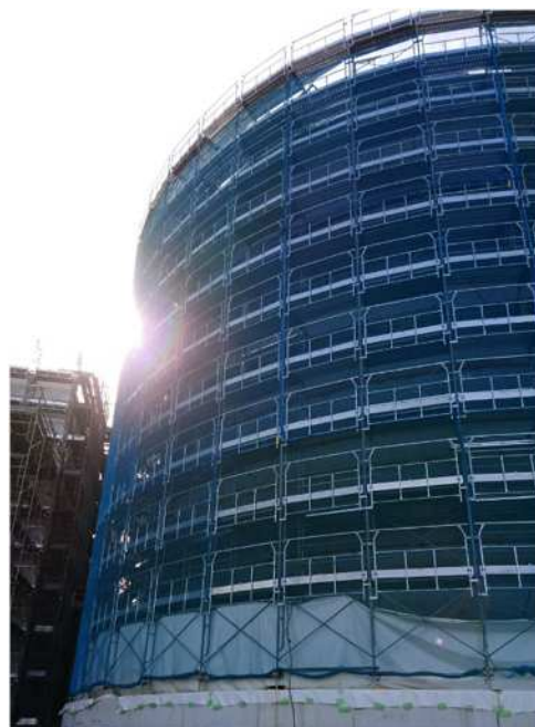
鋼板製消化タンク本体の建設状況
