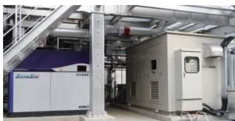
スクリュ式蒸気発電機(左)とバイナリ発電機(右)
