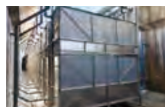
〈膜ユニットの設置状況例〉
