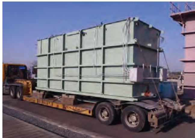
〈可搬式ユニットの運搬状況 (単槽式MBRユニットの反応タンク部)〉
