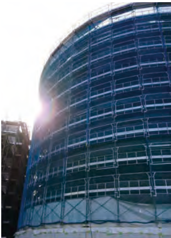
〈鋼板製消化タンク本体の建設状況〉
