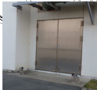
脱水用搬入箇所
