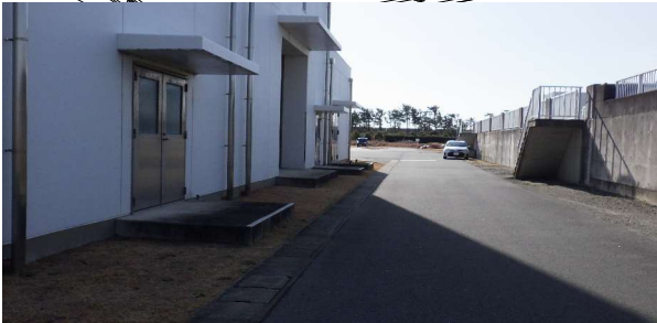
濃縮用搬入箇所
