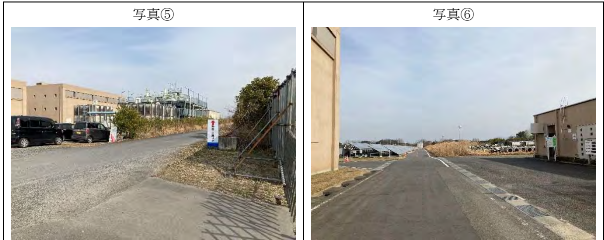
図-5 消化施設建設予定地（超高度処理実証施設）
