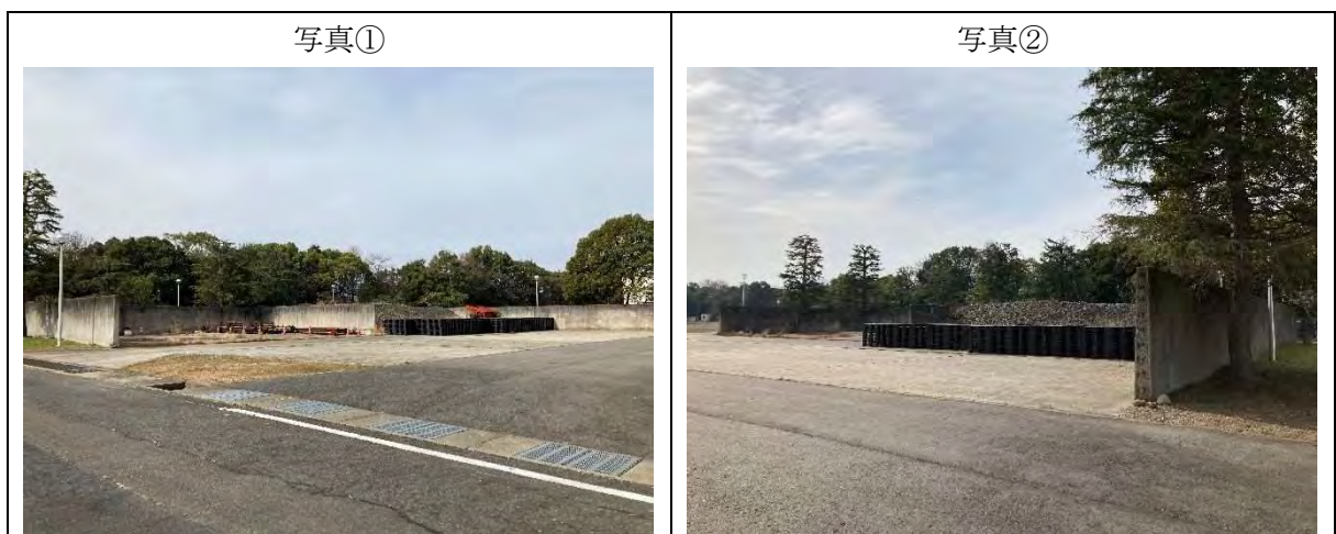
図-3 燃料化施設建設予定地（スラグストックヤード）
