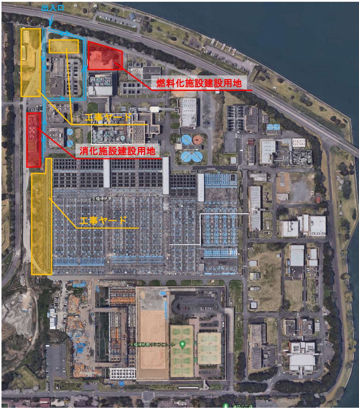
図 1.9 湖南中部浄化センター航空写真
