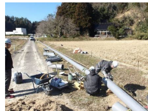
熊谷汚水中継ポンプ場から珠洲市浄化センターまでの仮設圧送管の布設 (国土交通省HP 災害・防災情報より)
