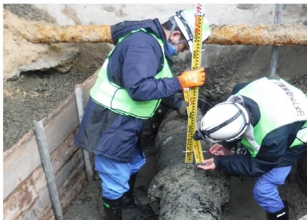
破断したポンプ圧送管の応急復旧（能登町）
