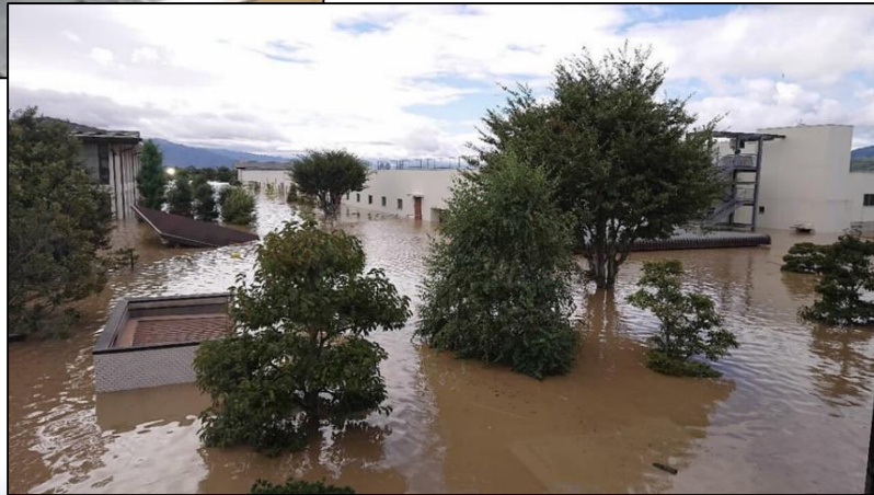
場内の水没状況→ (管理棟から撮影)
