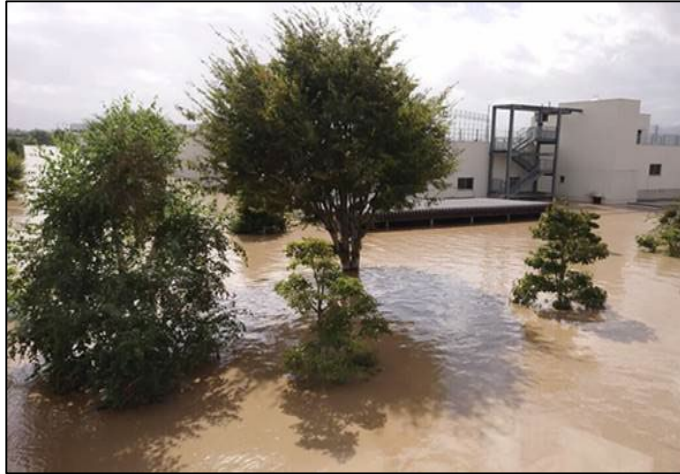
管理棟周辺の浸水状況
