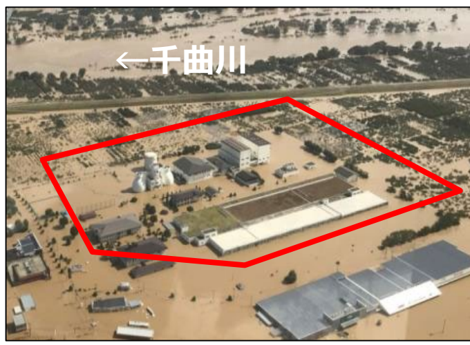
浸水状況(航空写真)
