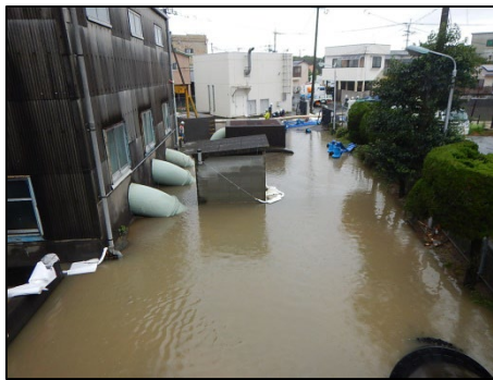
三川ポンプ場の浸水状況
