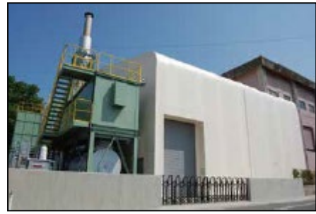
福島市堀河町終末処理場 下水汚泥乾燥施設
