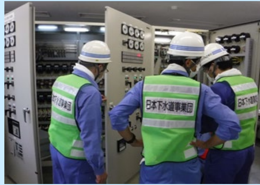
電気設備の調査
