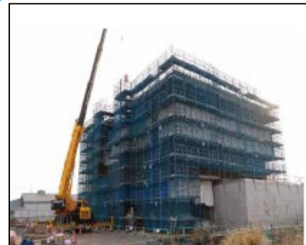
岩沼市二野倉第2排水ポンプ場 建設工事状況
