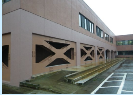
耐震鉄骨ブレース補強
