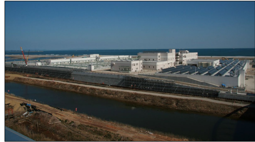
仙台市南蒲生浄化センター 建設工事状況
