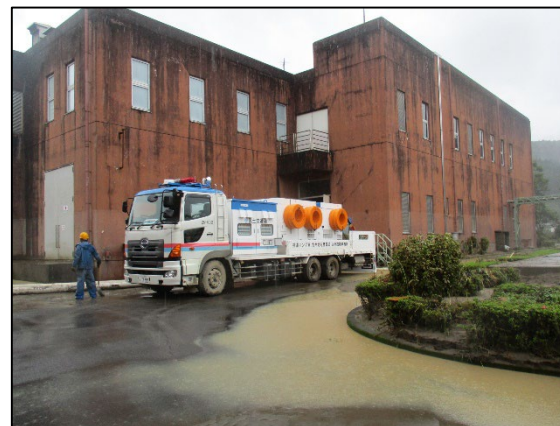
水没した機械棟下部の排水状況 (九州地方整備局の排水ポンプ車)
