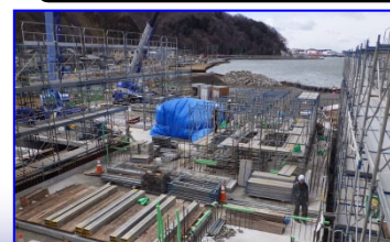
石巻市 井内第一排水ポンプ場 地上部躯体築造状況
