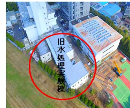
○：既存施設撤去→新寮室棟建設
