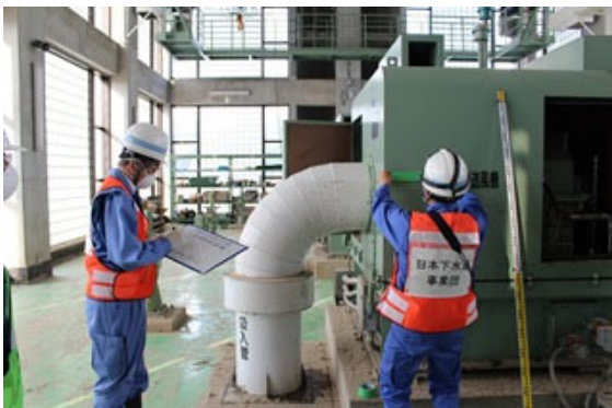
水処理曝気用送風機
