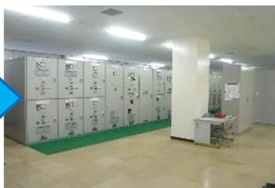
2階に電気設備を復旧
