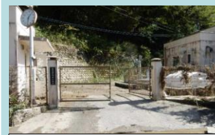
浸水状況(場内)
