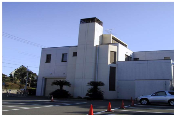
（葉山中継ポンプ場）
