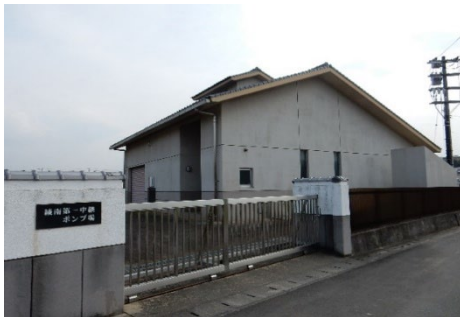
綾南第一中継ポンプ場
