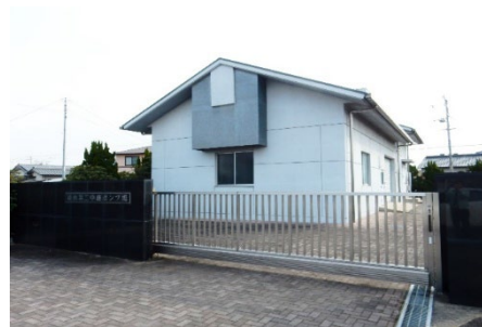
綾南第二中継ポンプ場
