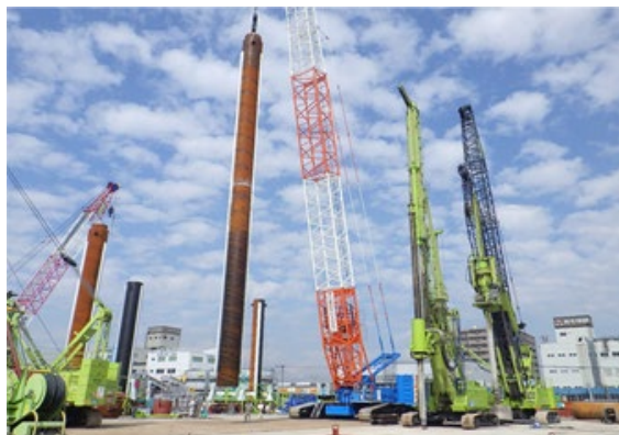
【写真 鋼管矢板建込状況】
