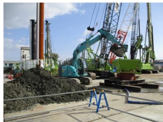
【写真 埋戻し状況】
