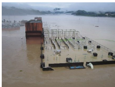
可搬式水処理施設により、機能喪失した下水処理場の機能を確保
