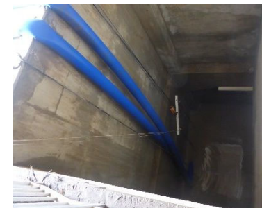
仮設ポンプとして揚水機能を確保
