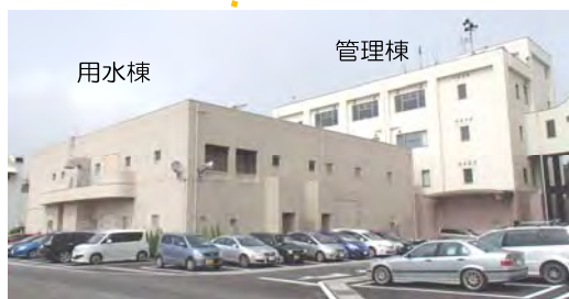
用水棟・管理棟
